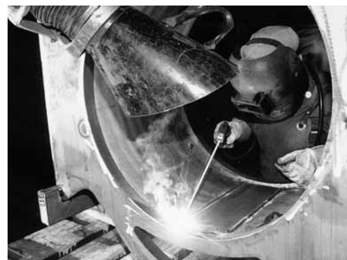
Fig. 4: dispositif flexible en forme d'entonnoir pour recueillir et aspirer les fumées de soudage.
