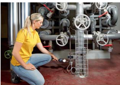
1 Contrôle du conducteur de protection.
