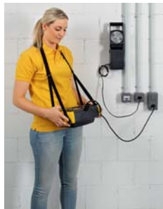
Règle 5 Contrôler l'installation avant la mise en service.
